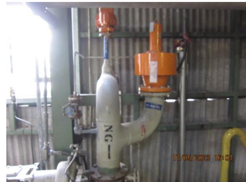
รูปที่ 37 Interlocking Valve และ Safety Relief Valve
